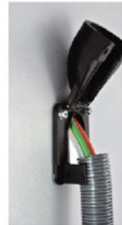
2. Insert conduit with cables
